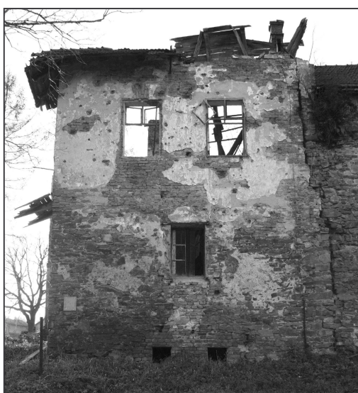
Obr. 9: Velká Polom (okr. Ostrava), detail průběhu spár mezi jižní a střední částí objektu (foto L. Augustinková 2008).
