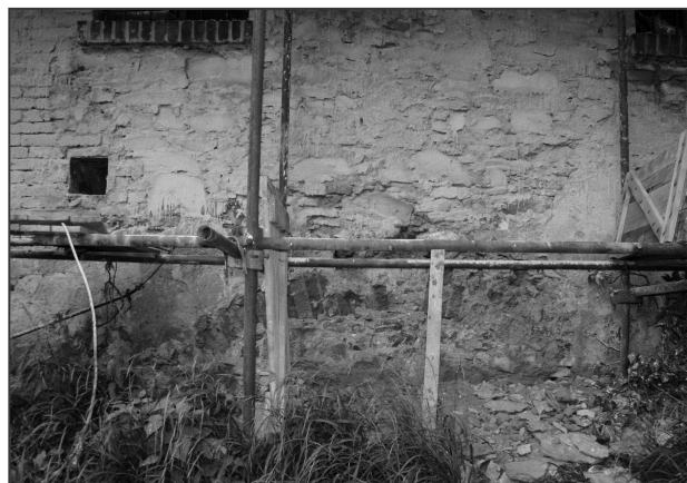
Obr. 19: Velká Polom (okr. Ostrava), severní průčelí severní části objektu – cihlový oblouk jako záklenuk nad přívodním kanálem (foto L. Augustinková 2009).
