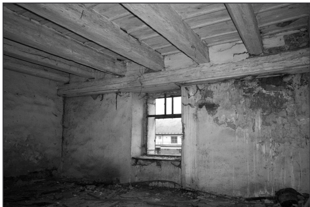
Obr. 13: Velká Polom (okr. Ostrava), místnost v patře střední části objektu s dodatečně vloženým rámem (foto L. Augustinková 2008).
