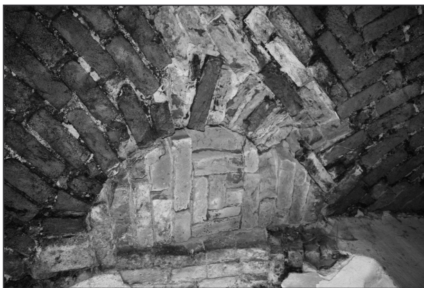
Obr. 17: Velká Polom (okr. Ostrava), místnost v přízemí střední části objektu, detail zazděného otvoru pro odtah kouře (foto L. Augustinková 2009).
