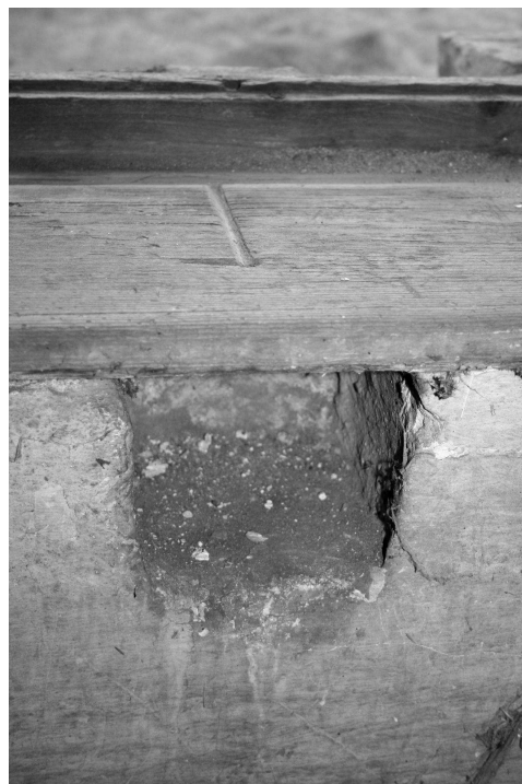
Obr. 15: Velká Polom (okr. Ostrava), detail parapetu s drážkou pro odvod rosné vody (foto L. Augustinková 2008).
