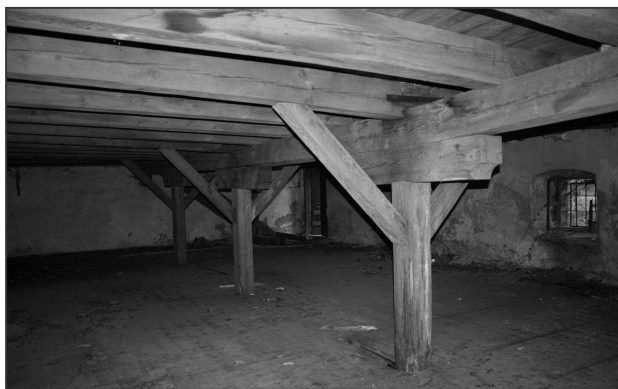
Obr. 11: Velká Polom (okr. Ostrava), přízemí sýpky v severní části (foto L. Augustinková 2008).
